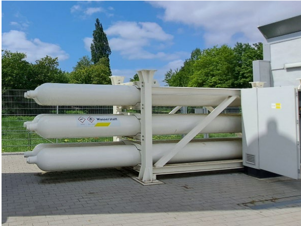
Bild: Wasserstoffspeicher an einer Tankstelle
