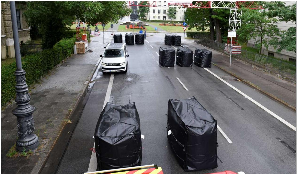
Abbildung 9: Ansicht einer temporären Anordnung von mobilen Sperrelementen als verschwenkten Durchfahrt
