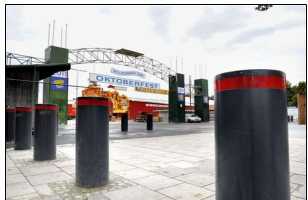
Abbildung 2: Polleranlage als festinstallierte, dynamische Sperreinrichtung
